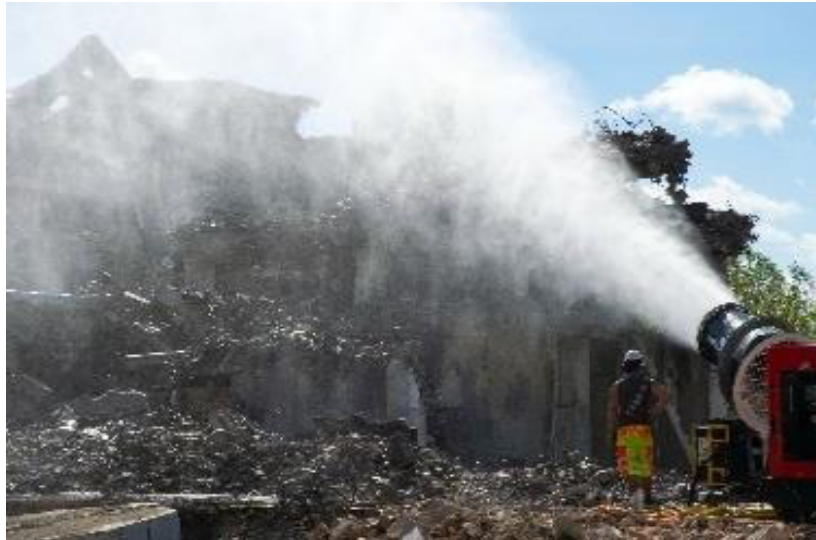
Fig. 9.3.10 Wetting Down Dust
