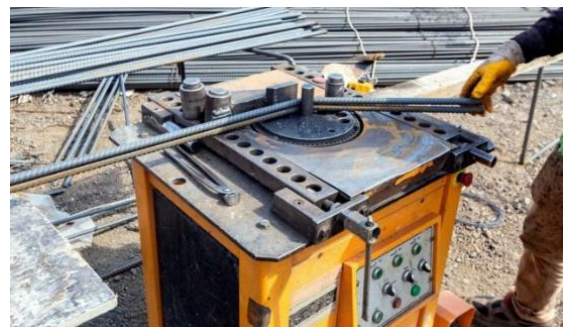
Fig. 1.1.11 Bar bending
