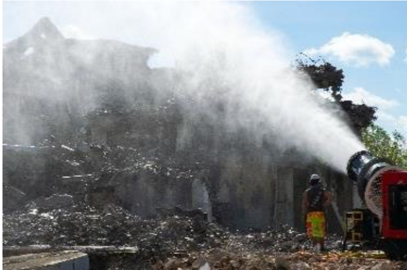
Fig. 9.3.10 Wetting Down Dust
